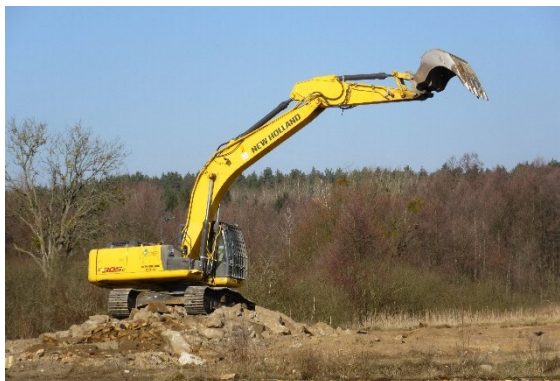
Abb. 1: Abriss und Entsiegelung 26.02.2015
