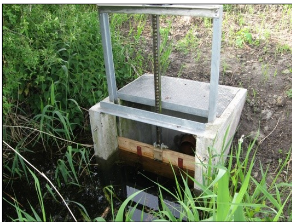
Erneuerter Stauer zur erhöhten Wasserhaltung Pflanzfläche direkt nach Anlage
