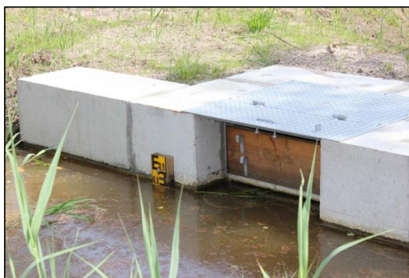
Abbildung 3: Vier rekonstruierte Staubauwerk sichern die Wasserhaltung der Teiche
